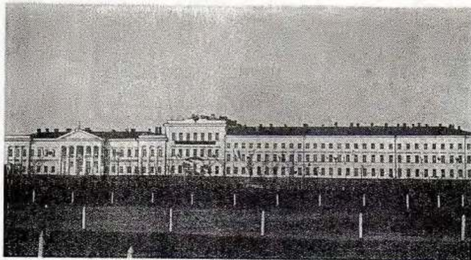
Передній фасадъ зданія, подвергнувшійся обстрѣлу красноармейцевъ 6-го февраля 1918 г
